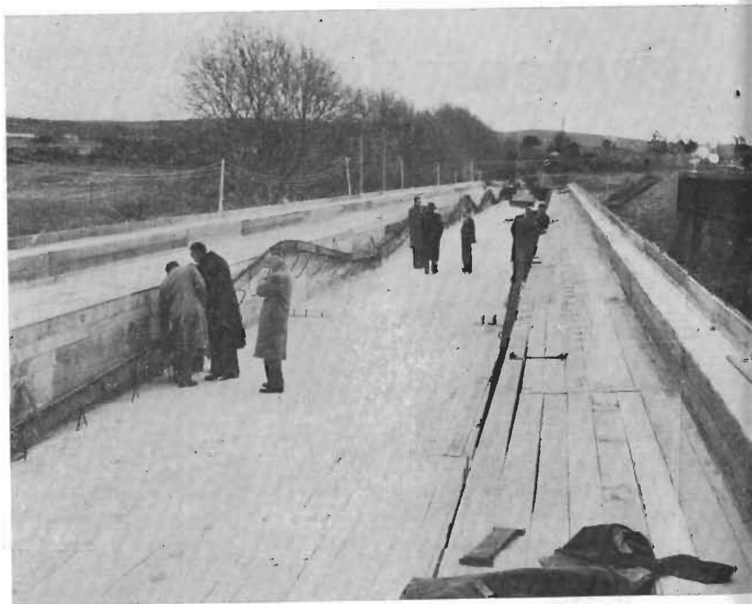
Fotografía 2 - Disposición de las vainas siguiendo la línea de los esfuerzos
