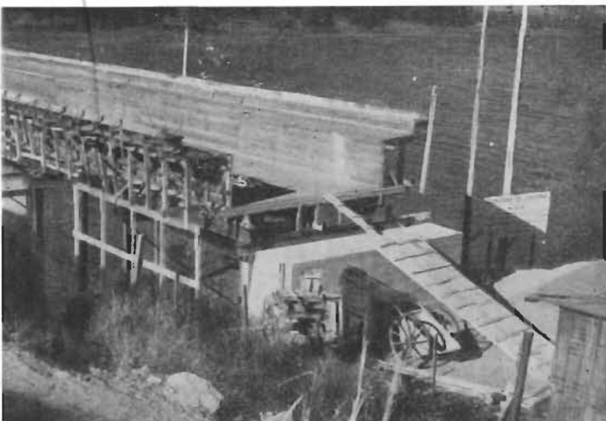
Fotografía 1 - Se observa el encofrado armado del puente, sin block de tesado
