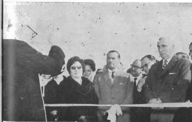
Bendición de las obras libradas al servicio público.
